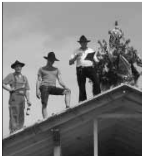
Nach einigen Hürden sowie Beratungen und Besprechungen wurde im Mai 2003 die Baugenehmigung für den Hüttenanbau erteilt. So konnte kurze Zeit später das Richtfest gefeiert werden.
